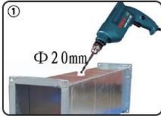
① 在非风管上打一个直径20mm的孔
